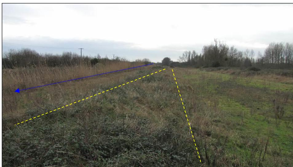
**Fig. 9. Douve de la Ramée (en bleu) et merlon en rive gauche (délimité par les pointillés) avec ronciers et remblais sableux**
