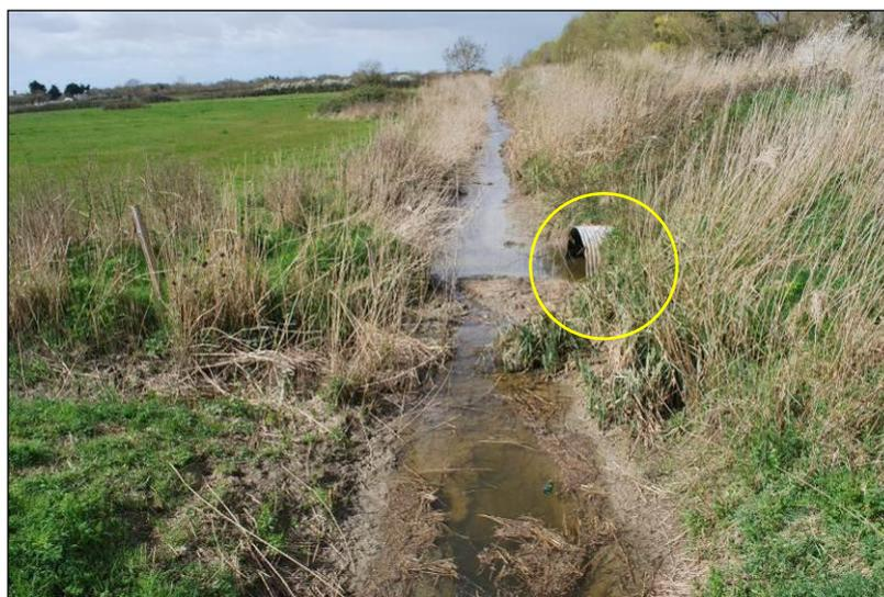
**Fig. 13. Migron et buse de la douve de la Ramée (entourée) à supprimer**
