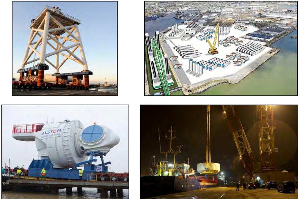
**Fig. 51.** *Manutention d'éléments de l'éolienne ALSTOM à destination du Carnet - Exemple de plateforme bord à quai aménagée*
