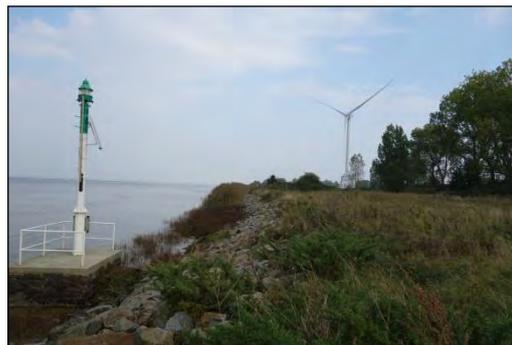
**Fig. 60. Côté est - Berge totalement artificialisée par des enrochements**
