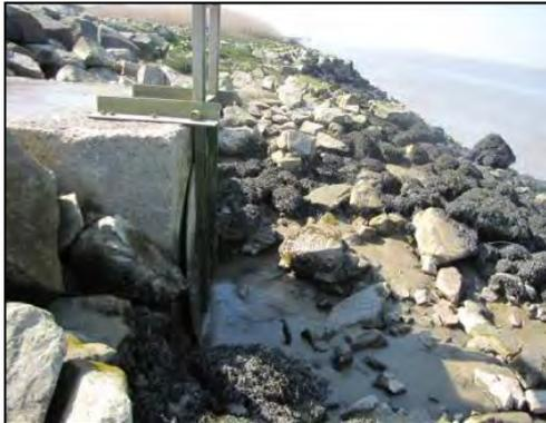
**Fig. 39.** Clapet anti-retour sur la douve de la Ramée à marée basse
