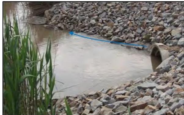
**Fig. 38.** Intrusion saline constatée sur l'ouvrage rénové à marée haute (coefficient de 95)
