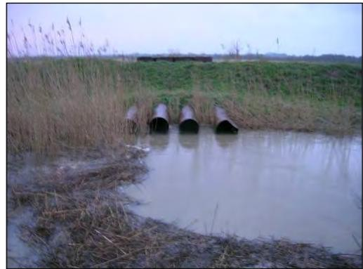
*Ouvrages de drainage historiques des dépôts de dragage partiellement en eau (exutoire vers la vasière de Paimboeuf)*
