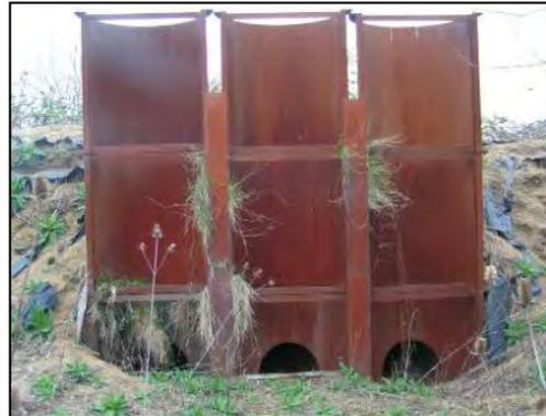
**Fig. 40.** Système de drainage des dépôts de dragage
