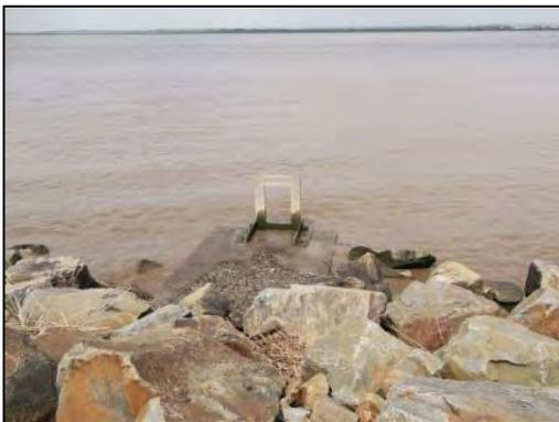
**Fig. 41.** Clapet anti-retour sur la douve de la Ramée à marée haute
