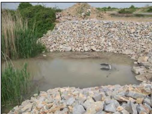
**Fig. 37.** Clapet anti-retour sur la vasière de Paimboeuf à marée haute (coefficient de 95)
